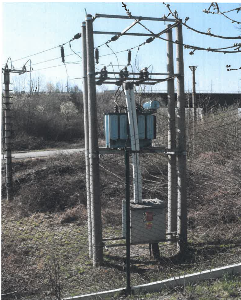
2. Odstranění stožárové trafostanice a demolice základové patky
